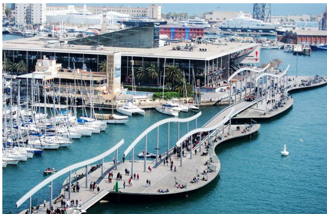
Рис. 2. Парадное общественное пространство на воде: разводной пешеходный мост Рамбла де Мар в Барселоне
